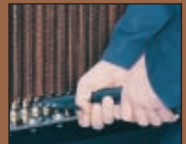
El tubo nuevo se ajusta al sello inferior utilizando la herramienta manual finalizando la reparación.
